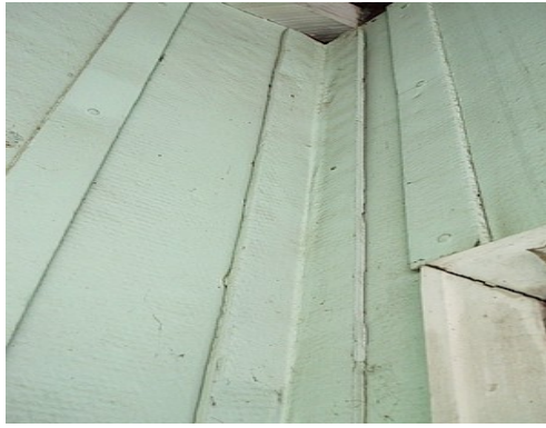
Inward corner section
